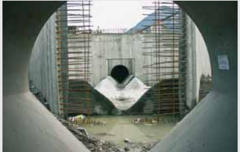
Im Gegensatz zu den Kanalausleitungen wird der Au- bzw. Nasottbach nur in den Schleppkanal geleitet, wenn die III Hochwasser führt.
