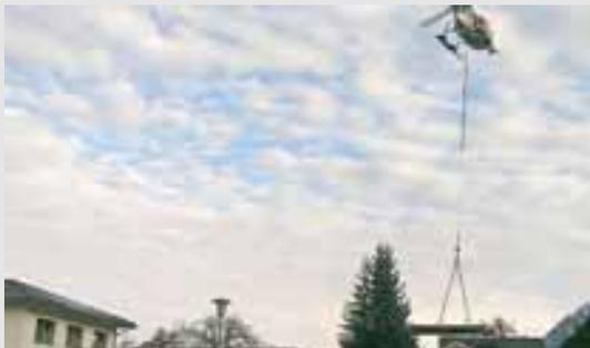
In Motten zeigten sich knapp oberhalb der Wohnhäuser Risse in einem Hang. Da 2005 ganz in der Nähe schon Muren abgingen, wurden die abrissgefährdeten Bereiche mit einer Krainerwand gesichert. Um den Flurschaden möglichst gering zu halten, wurden die benötigten Baumstämme, langlebige Robinien, mit dem Hubschrauber zur Baustelle geflogen. Diese Sicherungsmaßnahmen wurden im Herbst 2007 durch die Wildbach- und Lawinerverbauung abgeschlossen.
