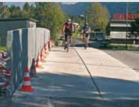
Zwischen der Holzbrücke und dem Schwimmbad wurde der Radweg von 2,0 m auf 3,0 m verbreitert. Bei der Mengbrücke wurde die gesamte Radwegbreite auf Gehsteigniveau angehoben. Der Radfahrer ist somit vom motorisierten Verkehr baulich geschützt.
