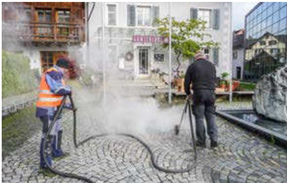
Bei engen Verhältnissen wird das Gerät von Hand geführt. Ein Helfer kümmert sich um den Schlauch.
