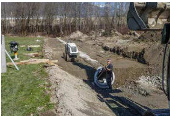
Das alte Betonrohr mit 30 cm Durchmesser wurde gegen ein 80 cm dickes Rohr ausgetauscht.
